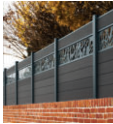
Pose sur muret
